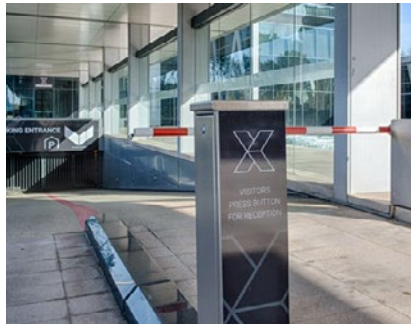
Herkenbare aanduiding van de ingang van de parkeergarage op weerbestendige dibond panelen.
